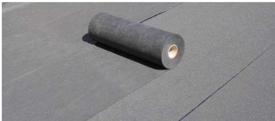
Рисунок 13.4 – Улаштування рулонної покрівлі
