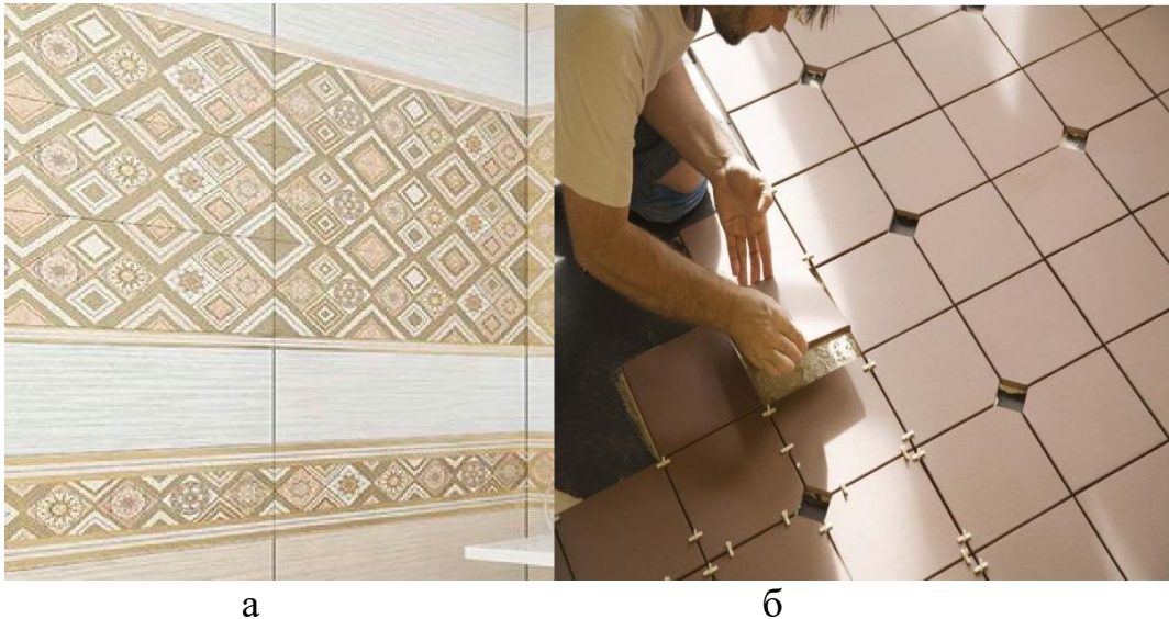
Рисунок 5.5 – Керамічні плитки різного призначення: а – для стін; б – для підлоги
