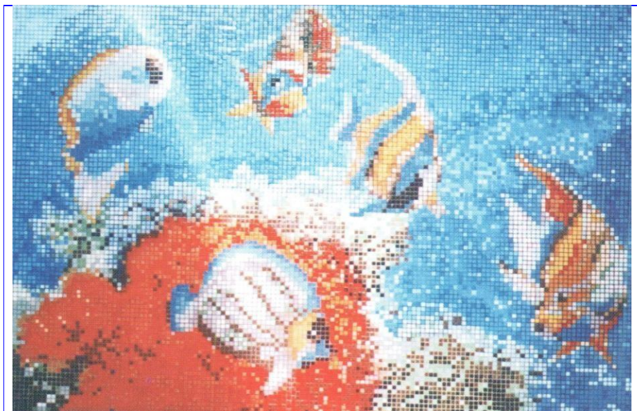
Рис. 5.7. Облицювання стін мозаїчними скляними плитками.
