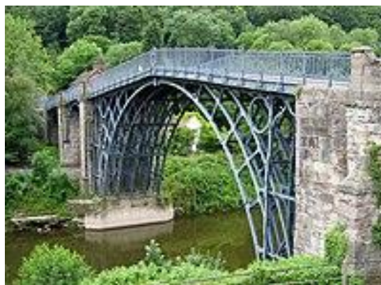
Мал. 30. Залізний міст — перший у світі арковий міст, виготовлений із заліза (чавуну), Велика Британія
