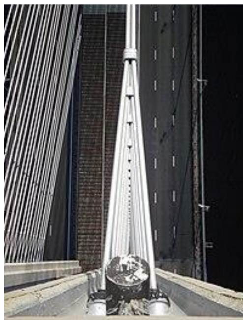
Мал. 33. Кріплення вант Південного моста у Києві
