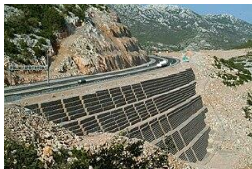
Мал. 11. Похила підпорна стіна з габіонів уздовж залізничних колій (Хорватія)
