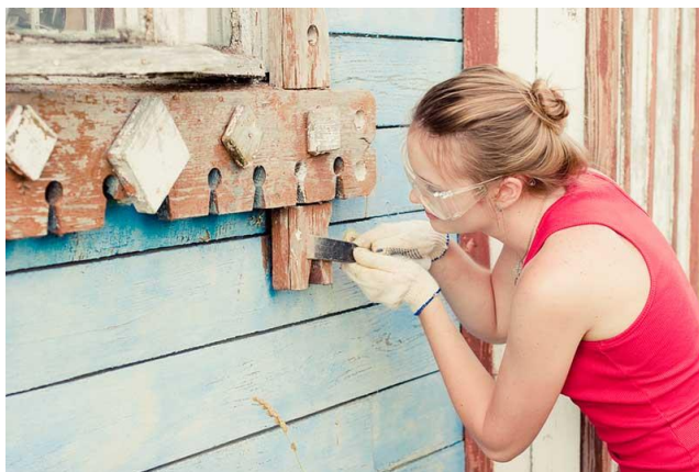
Рис. 3.3.1. Очищення поверхні
